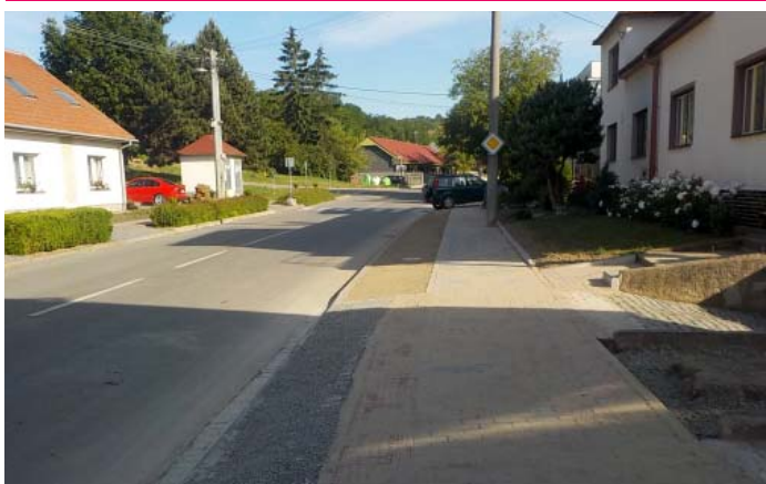
Opravený chodník v ulici Pod Břehy
