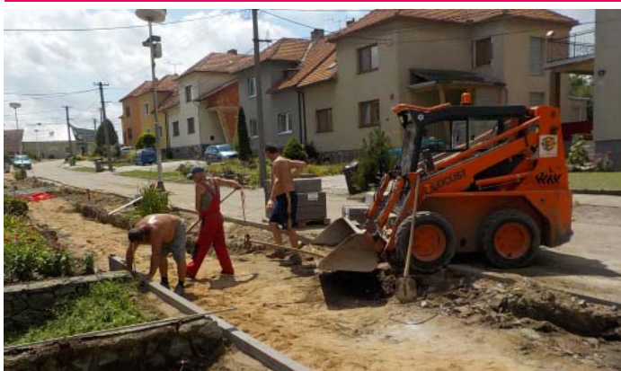
Oprava chodníku v ulici V Sadech
